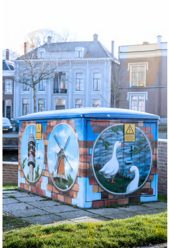
Transformatorhuisje aan de Antonides Van de Goeskade in Goes. De beschrijving is gerealiseerd door Galerie-Atelier De Kaai, een werkplaats voor beeldende kunstenaars met een beperking
